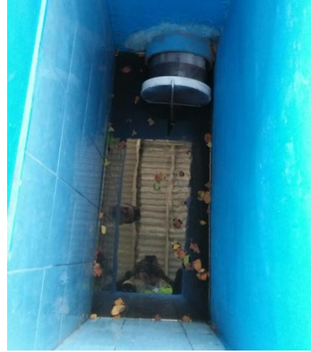
Filter dengan media ampas teh sebagai Adsorbent
